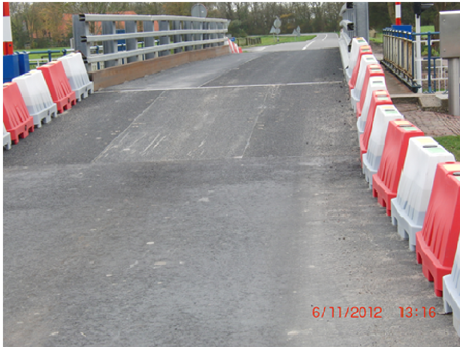
Noodbrug over Westfriesesluisbrug
